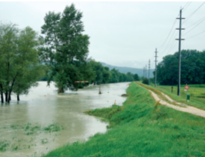
Hochwassersituation am 9. August 2007 bei der Walperswilerbrücke.
