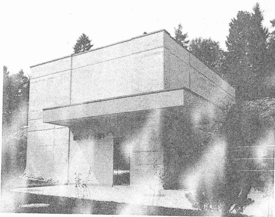
Reservoir-Neubau «Oberholz» in Mörigen
