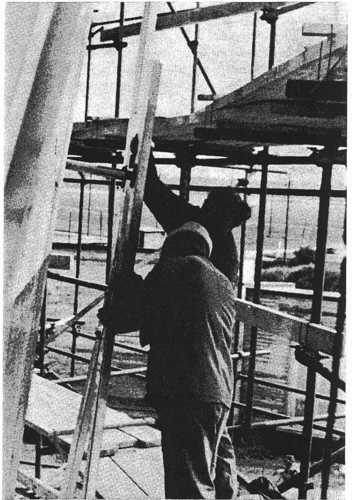
Montage der Aluman-Blech- elemente am Wasserturm
