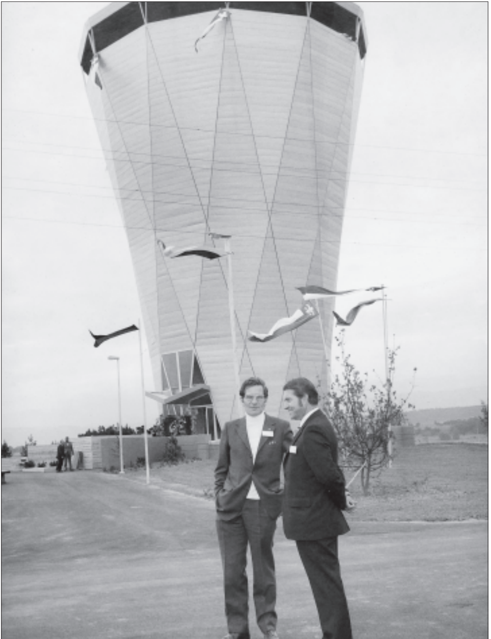
Um die rund 100 000 Einwohner mit sauberem Trinkwasser zu versorgen, wick die damals gegründete Wasserverbund Seeland AG (WVS) der Abwasserfahne der Zuckerfabrik aus und wurde in der Gimmiz-Ebene fündig. Sichtlich erfreut darüber, die beiden damaligen WVS-Verwaltungsräte Fidel Linder (links), Gemeinderat in Biel, und Anton Mäder, Gemeindepräsident in Lyss, anlässlich der Einweihung des Gimmiz-Wasserturms im Frühjahr 1974. (Bild: F. Probst)
